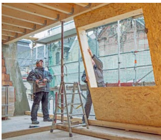
↑ Die Konstruktion der Wand- und Dachbauelemente, die individuell und nach Maß vorgefertigt werden.
