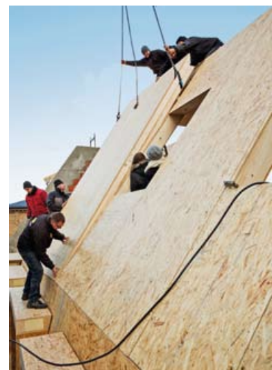
↑ Hoch wärmegeämmt Fertigteile: absenken, einpassen, anschrauben – und fertig.
